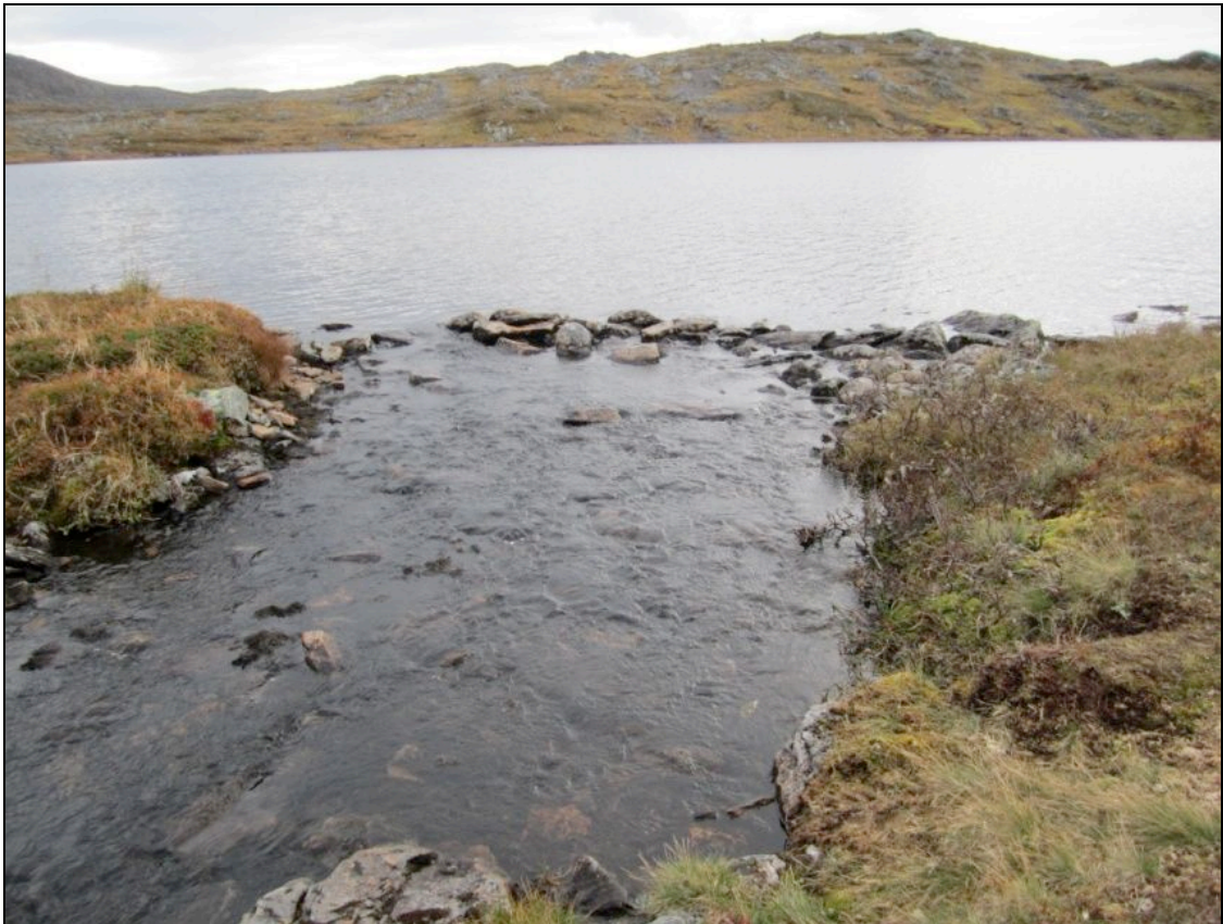
Figur 9. Utløpet fra vatn 271 hvor hoveddelen av vannet går til Storelva. Her planlegges det å bygge en betongterskel som vil føre til at vannet snus mot Storbuktvatnet. Foto: Finnmark Kraft AS.
