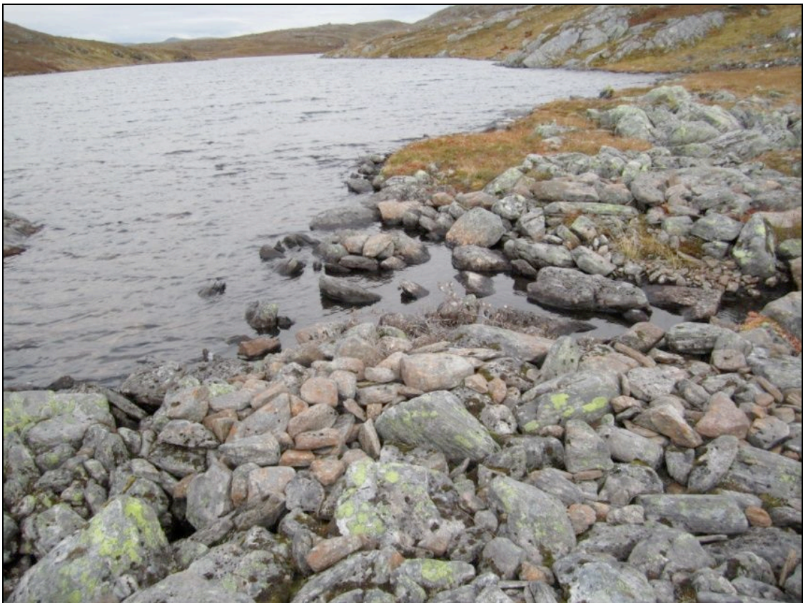
Figur 8. Utløpet fra vatn 271 hvor vannet går ned til Storbuktvatnet. Steinmassene i utløpet vil bli flyttet på slik at man får en bedre avrenning. Foto: Finnmark Kraft AS.
